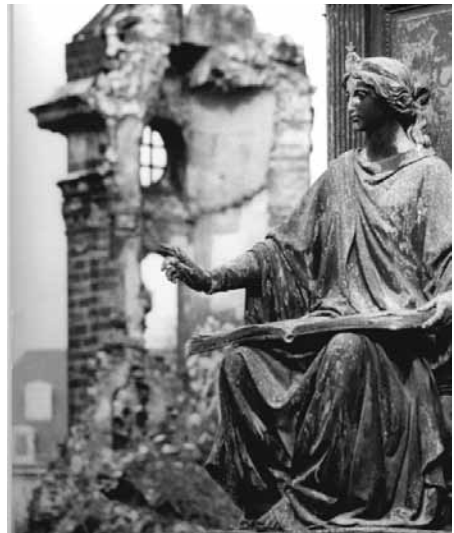
Die zerstörte Frauenkirche in Dresden
